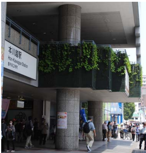
<本川越駅の壁面緑化>
