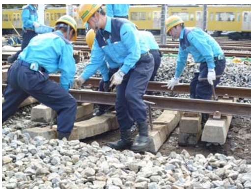
(線路陥没の復旧)
