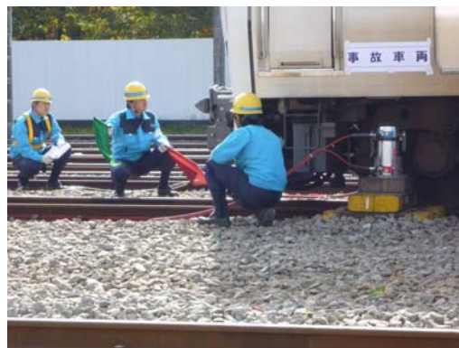
(脱線車両の線路への復旧)
