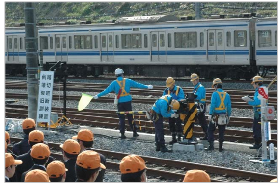
(電気部：踏切遮断機倒壊復旧訓練)
