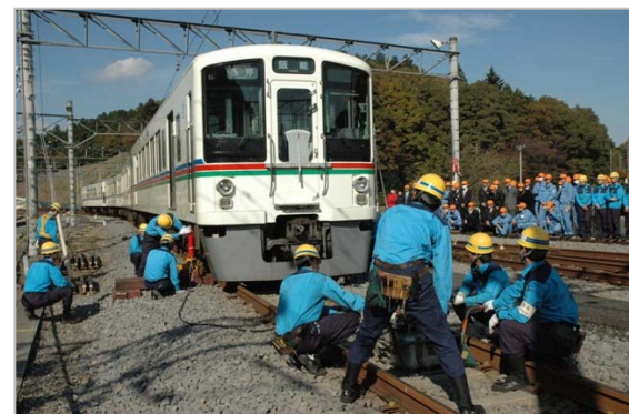
(車両部：脱線復旧訓練)
