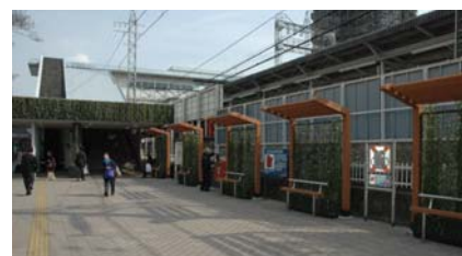
<屋根上およびベンチ部に緑化を施した小手指駅北口>
