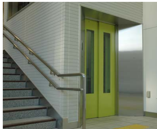
北口改札外にスロープの代わりに新設された エレベーター
