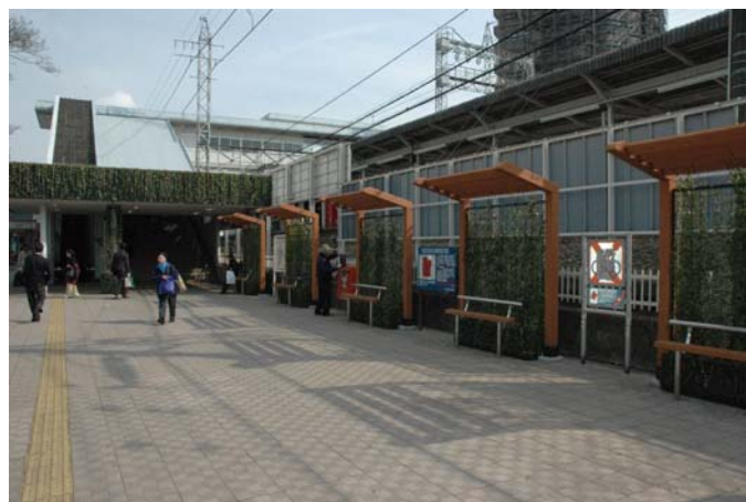
小手指駅北口屋根上 北口駅前広場の緑化と設置されたベンチ
