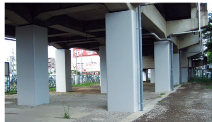
高架橋耐震補強(小川～玉川上水駅間)
