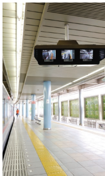
点字誘導ブロック
